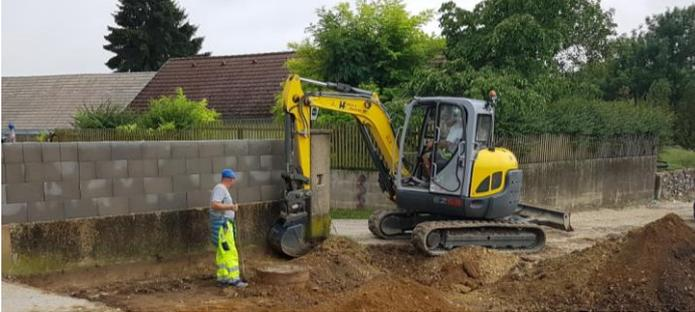
Im Juni wurden vorweg im Auftrag von EVN-Wasser Schieber ausgetauscht. Von der vom Gemeinderat beauftragten Firma Held & Francke wurde zuerst die Regenwasserkanalisation erneuert. Danach wurden die Arbeiten mit der Herstellung des Unterbaues und dem Setzen der Randsteine fortgesetzt. Noch im September konnte das Projekt mit den Asphaltierungsarbeiten abgeschlossen werden.
