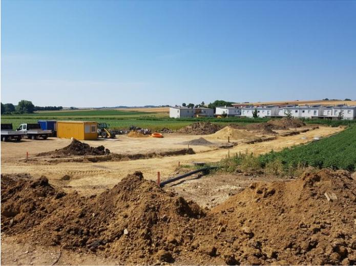
Firma Held & Francke wurde seitens der Gemeinde mit den erforderlichen Bauarbeiten beauftragt, welche bereits in Angriff genommen wurden. Zuerst wurde die Humusschicht abgetragen. In weiterer Folge wird der Regenwasserkanal verlegt. Danach folgen die EVN-Leitungen und die Vorbereitungsarbeiten für die Straßenbeleuchtung.
